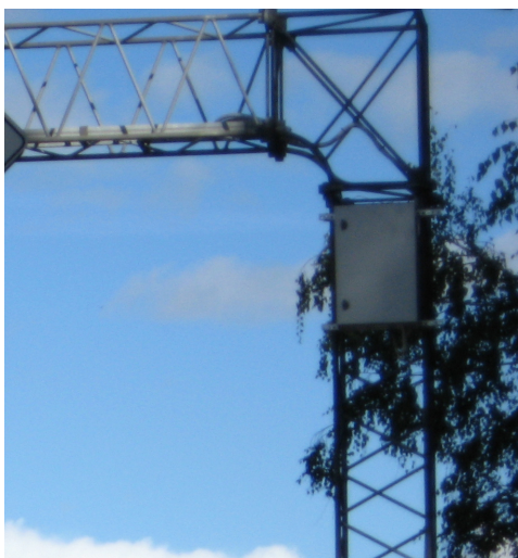
Att. 4.3: Dators ar komponentēm, kurš izvietots āra apstākļiem atbilstoša ietvarā
