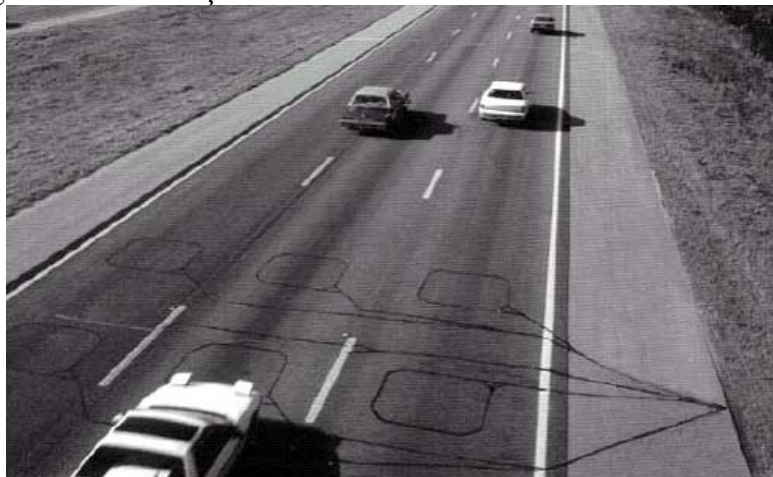
2.1. Attēls. Induktīvās cilpas izvietojums uz brauktuves
